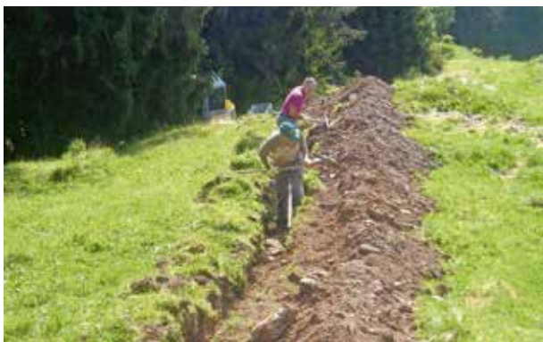
Zuleitung zum Tränkeplatz
