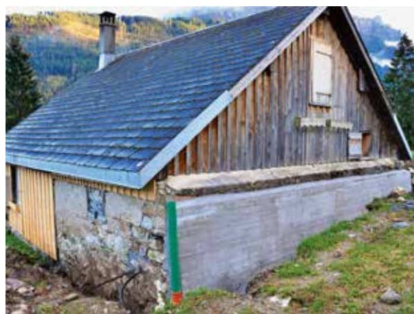
Gebäude Alp Bödem
